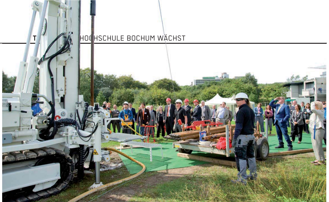
Es war ein Spatenstich der etwas anderen Art: Startsignal für den Neubau des Geotechnikums an der Hochschule Bochum war am 6. September 2011 ein „Anbohren“ mit NRW-Staatssekretär Udo Paschedag.
